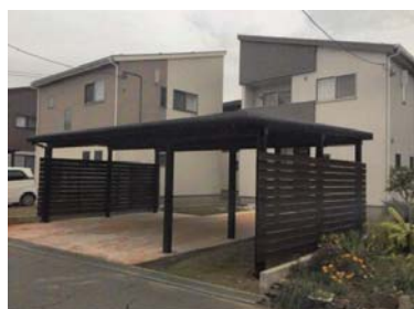
カーポートの設置
