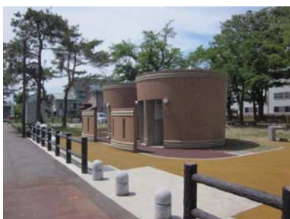
摂田屋公園トイレ整備
