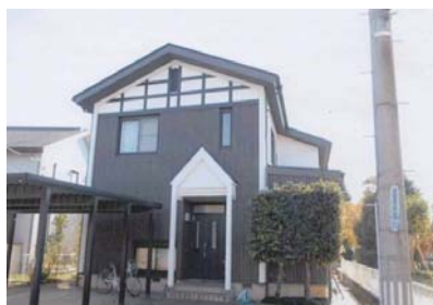
外壁の張替、屋根・外壁の塗装
