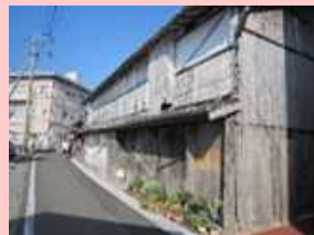
空き家の除却
