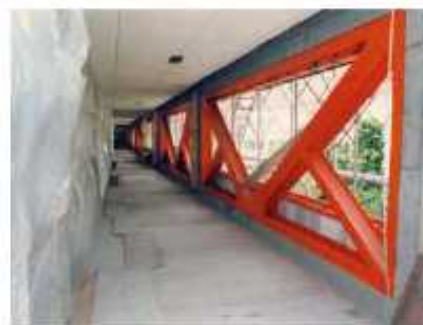
鉄骨ブレースによる壁の補強
