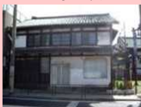
空き家の活用
