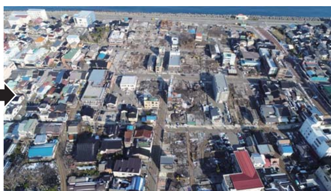
H29.2.15(大火から55日後) ※地上ガレキ撤去
