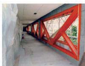
鉄骨ブレースによる壁の補強
