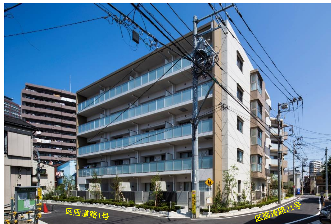
主要生活道路21号線・区画道路1号より
