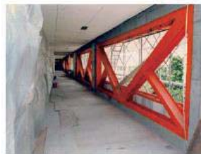
鉄骨ブレースによる壁の補強
