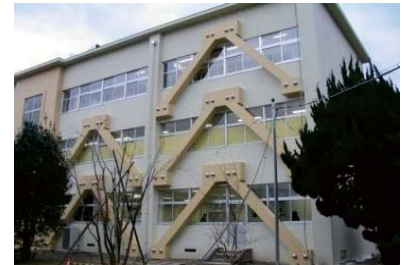
鉄骨ブレースによる壁の補強
