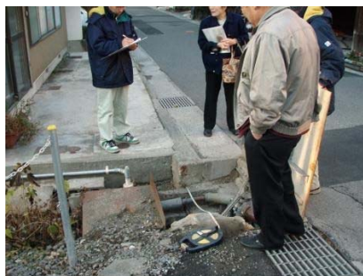
電柱移転先の用地交渉
