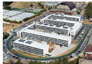
女川町・陸上競技場跡地地区200戸 (H26.3完成)
