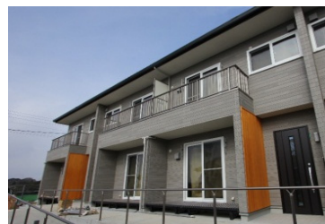
塩竈市・浦戸桂島地区13戸 (H27.12完成)
