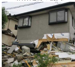
＜隣棟建物の衝突＞
