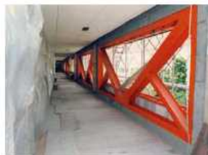
鉄骨ブレースによる壁の補強
