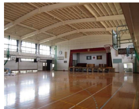
< 吊り天井を撤去した体育館 >
