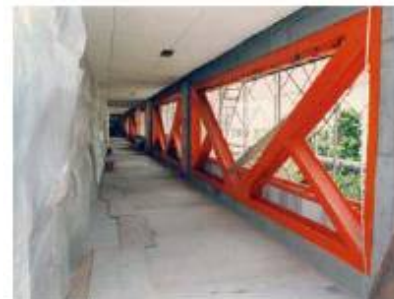
鉄骨ブレースによる壁の補強
