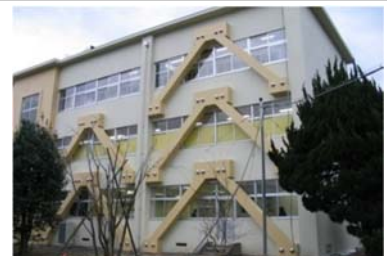
鉄骨ブレースによる壁の補強
