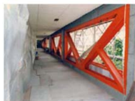
鉄骨ブレースによる壁の補強
