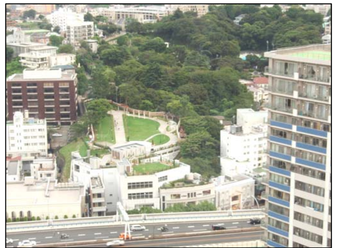
▲工事完了時（H21.8）
