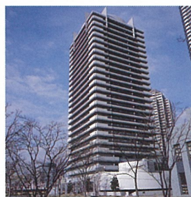
11 三菱重工ポートサイドビル
