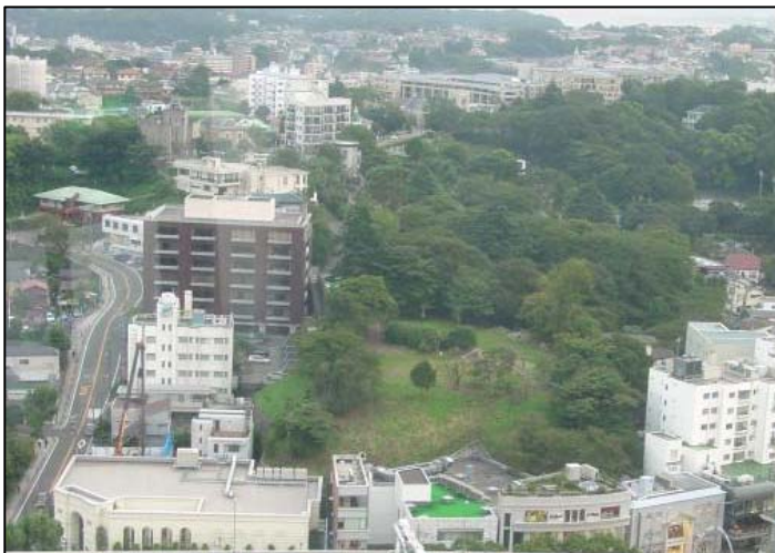
▲建築工事着工前（H18.9）
