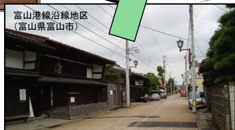
道路の高質化(カラー舗装)
